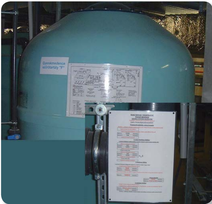
3. ábra: Medencetartály a szükséges műszaki információkkal
