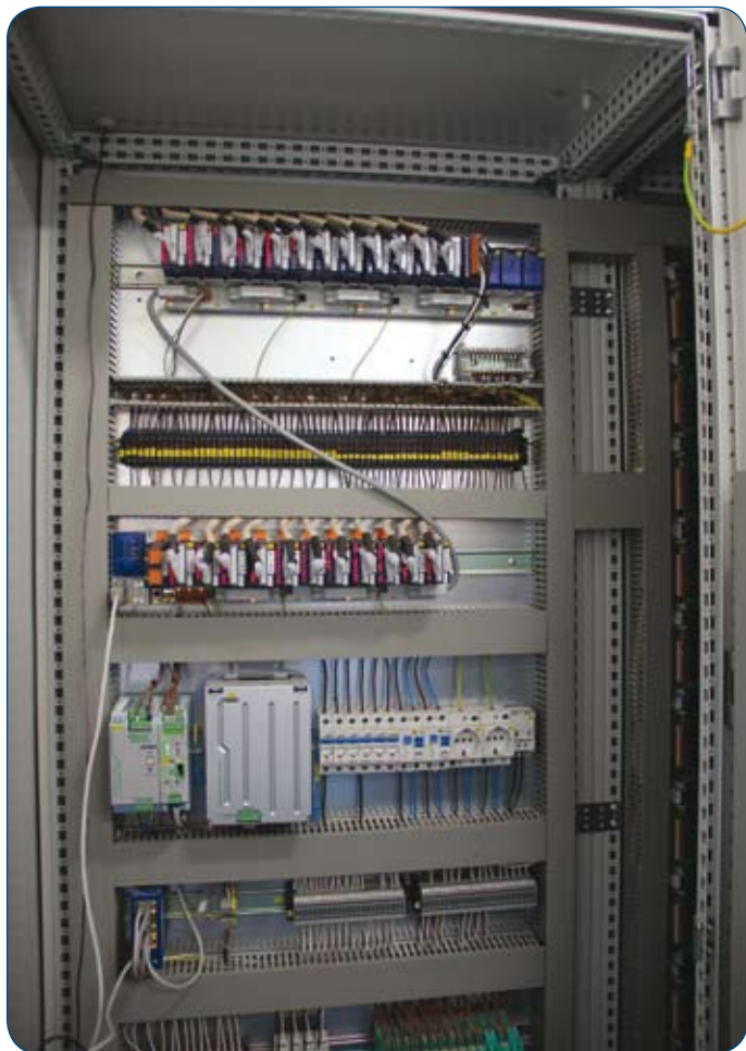
7. ábra: A vezérlőszekrény kialakítása a PCD3-mal és a panelekkel
