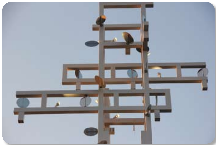
2. ábra Reflektorok és motoros tükrök a tornyon
