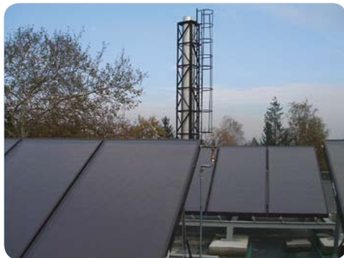
2. ábra Napkollektorok, a háttérben az faaprítékkazán kéménye
