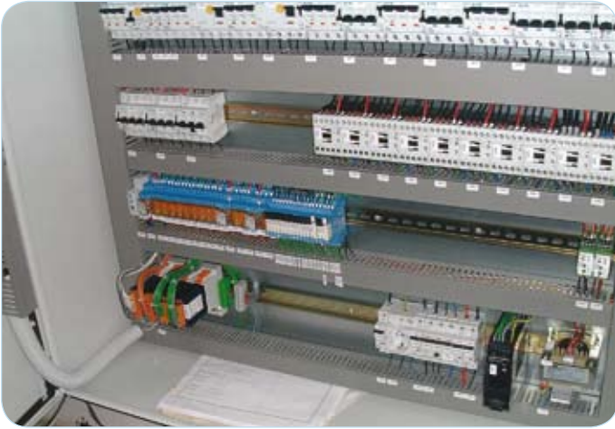
3. ábra Az egyik SAIA-vezérlőegység
