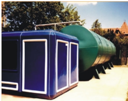
3. ábra A képen a visszasajtoló kút gépháza és puffertartálya látható
