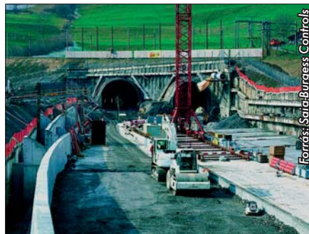
2. ábra Az alagúthoz vezető vágányszakaszcso alapozási munkálatai
