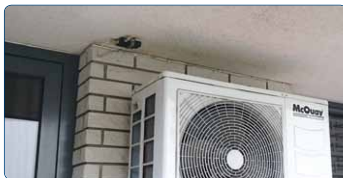
2. ábra A külső hőmérsékletmérés rossz példája
