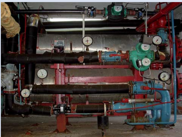
2. ábra A hőközpont a felújítás előtt
