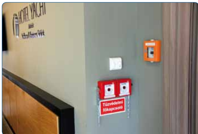
6. ábra A recepció falai érzékelő-szabályozója
